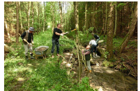
Reparatur eines Wasserverteilers. Foto: P. Lenk
