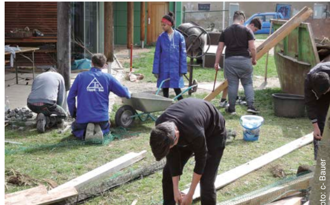
Bei der Renovierung der Volieren in der Vogelauffangstation.
