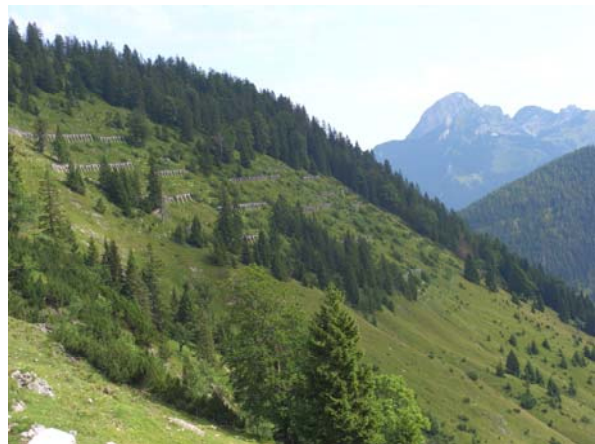
Abb. 1: Schutzwaldsanierung; Forstbetrieb Schliersee
