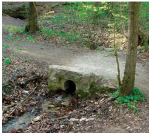
Abb. 32 und 33: Die Verrohrung an einem Quellbach wurde entfernt und durch eine Brücke ersetzt.
