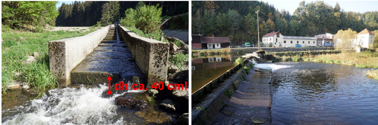
Abbildung 47: Links: Einstieg in die Fischwanderhilfe Teisnach; Rechts: Wehr KW Marienthal
