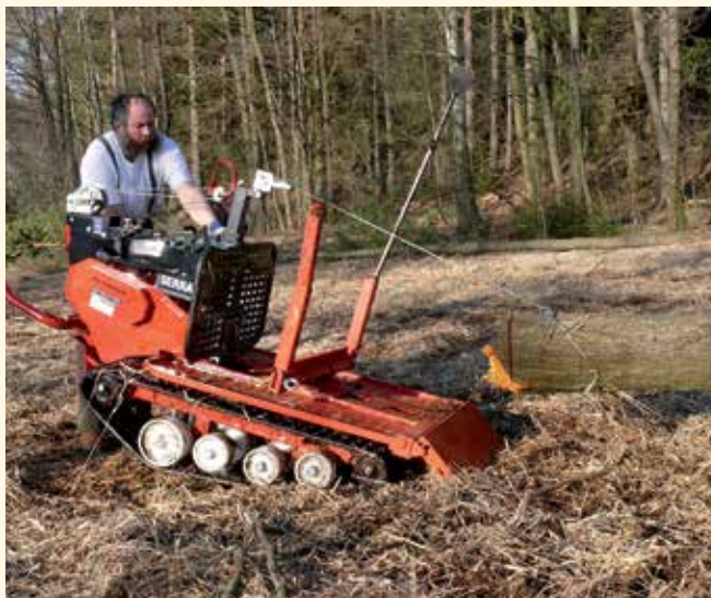
Mit dem „eisernen Pferd“ können mittels einer Seilwinde schonend Baumstämme aus empfindlichen Lebensräumen wie Mooren oder Quellbereichen entfernt werden - ideal für Renaturierungsarbeiten
