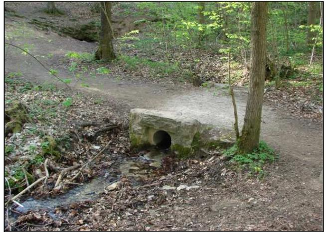
Zustand vor der Maßnahmenumsetzung: Trittschäden im Quellbereich (links), Verrohrung des Quellabflusses (rechts)
