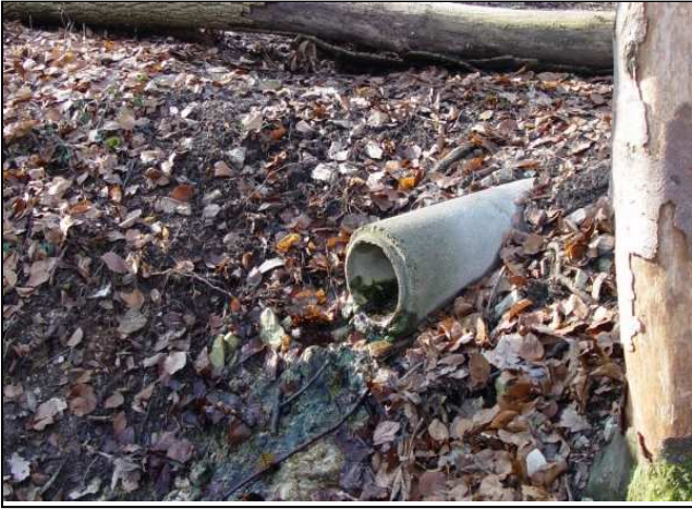
Zustand vor der Maßnahmenumsetzung: Absturz nach der Verrohrung (links), Bachlauf nach der Maßnahmenumsetzung (rechts)
