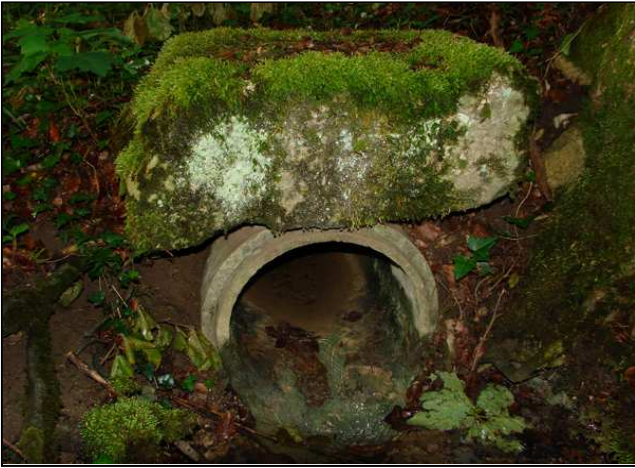
Zustand vor der Maßnahmenumsetzung: Verrohrung des Quellbachs (links), Betonrohr von innen (rechts)
