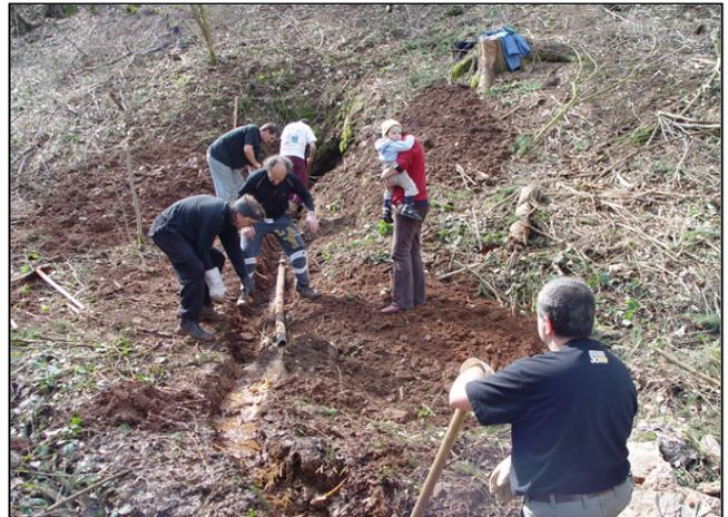
Maßnahmenumsetzung: Beseitigung der Verrohrung und Gestaltung des Quellabflusses (links und rechts)
