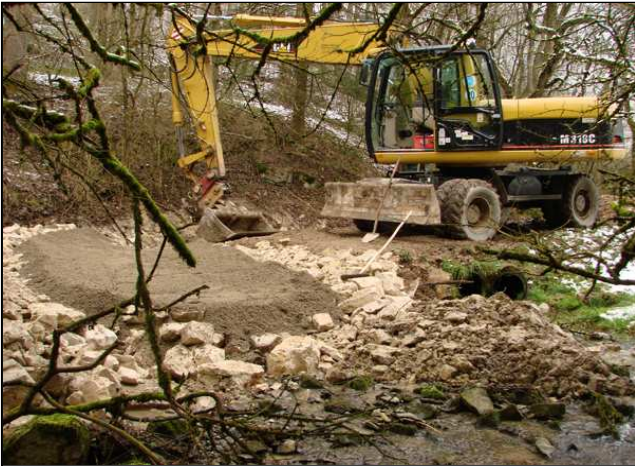
Maßnahmenumsetzung: Bau der Furt – Tragschicht (links) und Gestaltung der Oberfläche (rechts)
