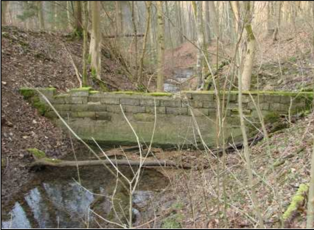
Zustand vor der Maßnahmenumsetzung: Anstauung des Quellbachs durch eine Betonmauer
