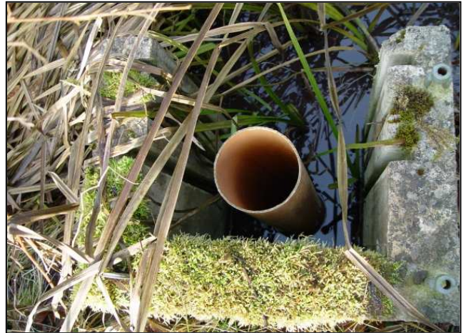
Zustand vor der Maßnahmenumsetzung: verlandeter Fischteich mit Quellzuflüssen (links), Teichmönch (rechts)
