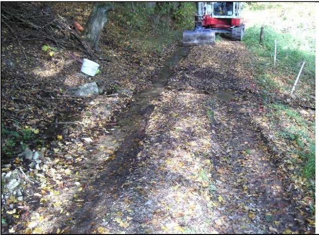
Zustand vor der Maßnahmenumsetzung: Quellabfluss durch die Befahrung stark beeinträchtigt, alte Verrohrung eingebrochen (links und rechts)
