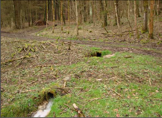
Zustand vor der Maßnahmenumsetzung: Verrohrung des Quellabflusses (links und rechts)
