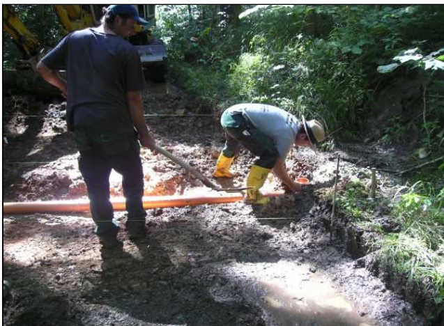
Maßnahmenumsetzung: Einbau der Hilfsleitung vor dem Furtbau (links), Gestaltung der Furt (rechts)
