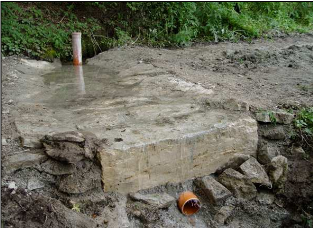
Maßnahmenumsetzung: Furt mit Hilfsleitung (links), gleiche Furt vor der letzten Bauphase (rechts)
