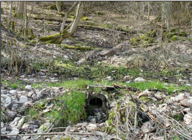
Zustand vor der Maßnahmenumsetzung: Verrohrung des Quellabflusses (links), Absturz nach dem Rohr (rechts)
