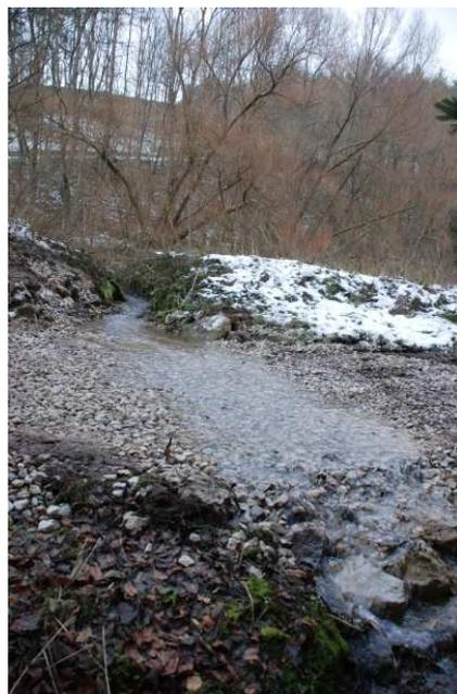
Zustand nach der Umsetzung: Furt ersetzt das bisherige Betonrohr (links und rechts)
