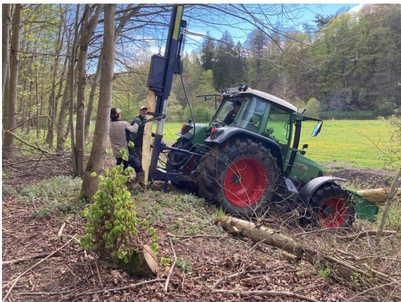
*Mit einer Pfahlramme am Traktor wird der neue Weidezaun gebaut*
