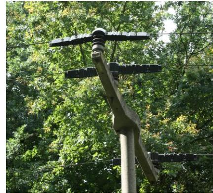
Mit der VDE-AR konforme Abdeckhaube auf einem Querträger mit Stützisolatoren
